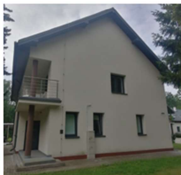
Elewacja tylna N
